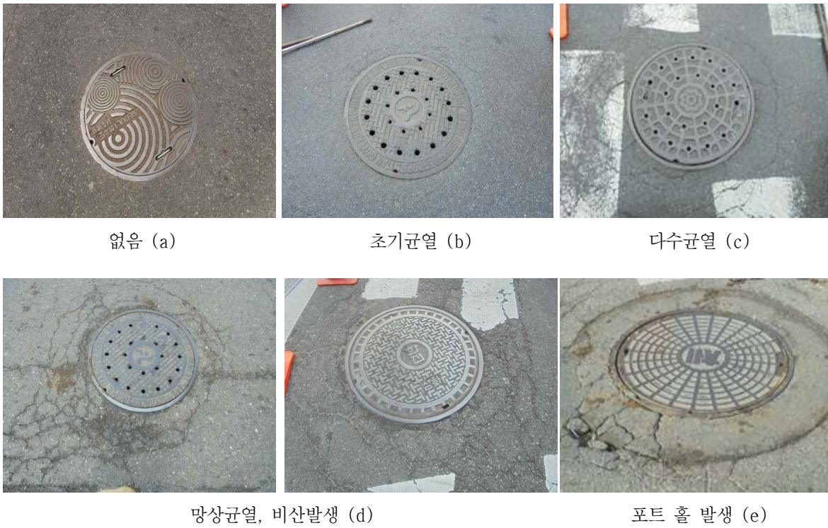
[그림 4.8] 주변포장 손상 상태평가 기준(예시)
