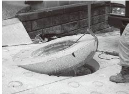
Parabora 공법의 구조 및 절단전경
