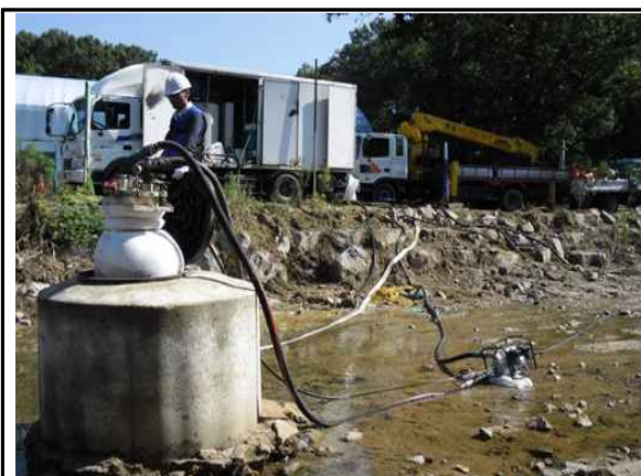
공기를 이용한 라이닝 경화 및 양생
