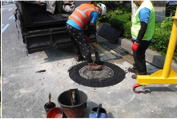
아스콘 공장운반 후 포설전경
