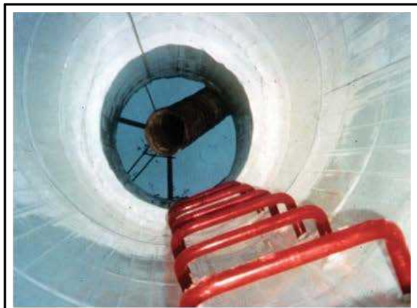
콘크리트 라이닝 설치 전경
