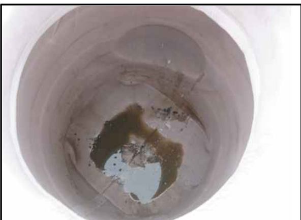
라이닝 경화 후 내부 전경
