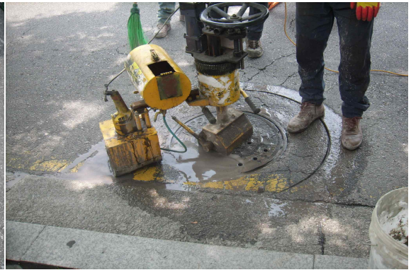
습식절단작업의 오염원 발생 전경
