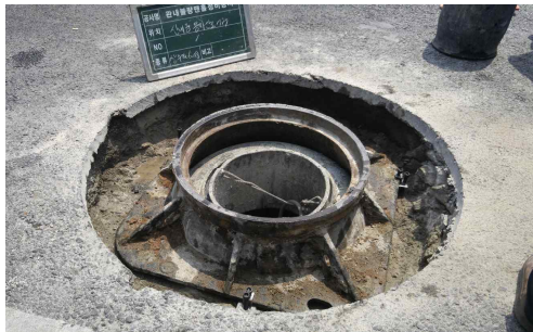
브레이커 작업에 의한 과굴착 전경
