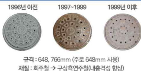
[그림 2.9] 하수도 맨홀(작업구) 뚜껑형태변화 및 내부구조
