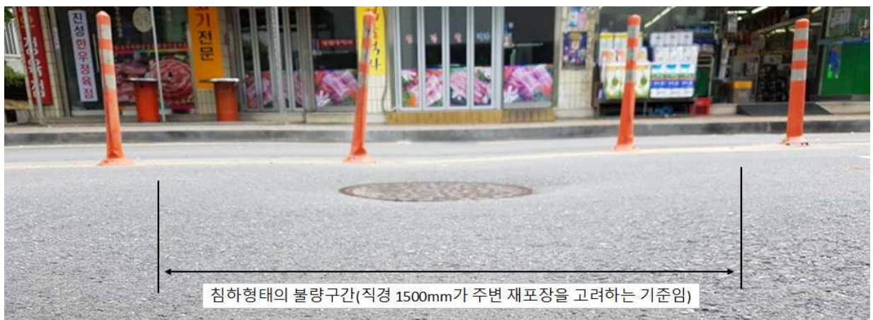
〔그림3.2〕 침하형태 불량구간 예시
