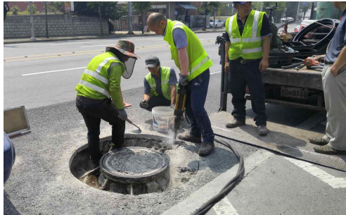
브레이커 작업 전경
